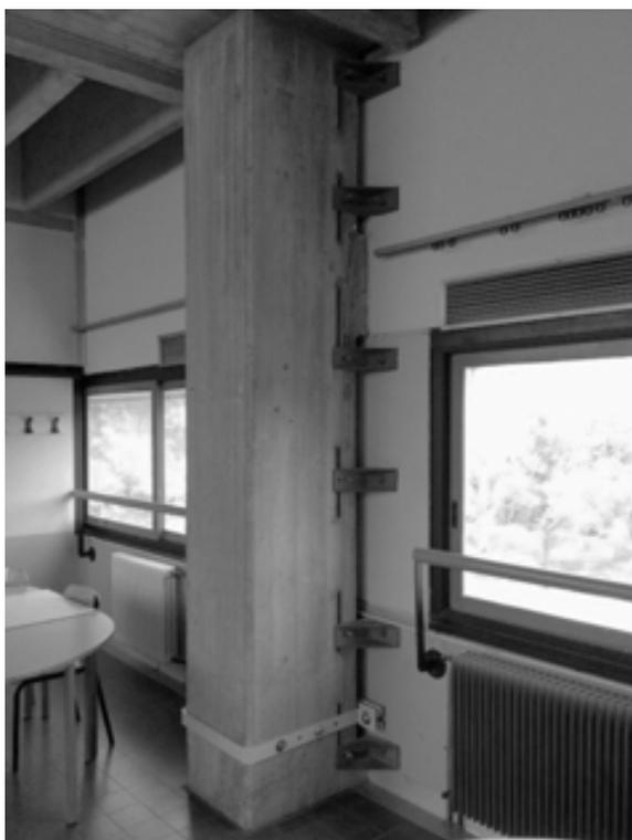
*Fig. 17 Un pilastro al quale sono stati aggiunti angolari per trattenere l'involucro esterno*
